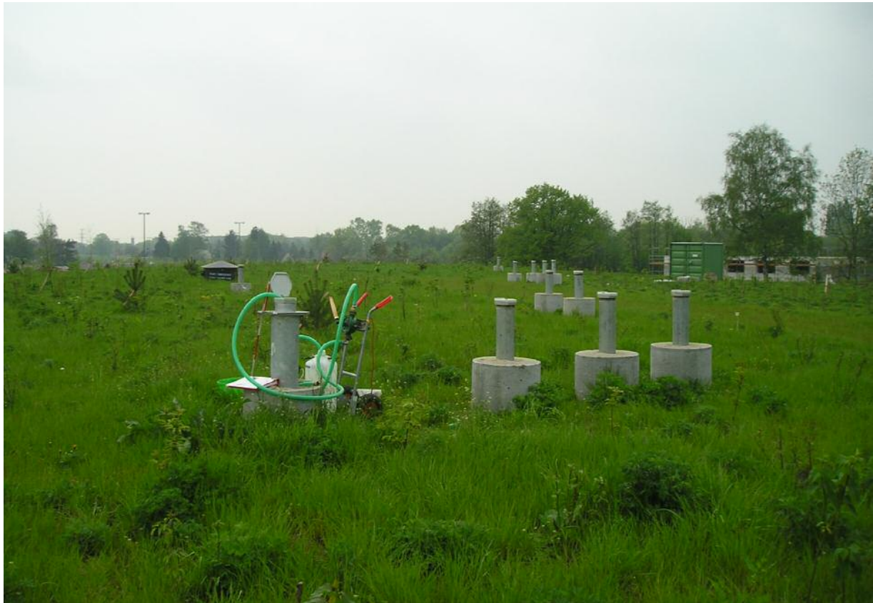
Abbildung 9 Messstellen auf der ehemaligen Deponie Eckerkoppel
